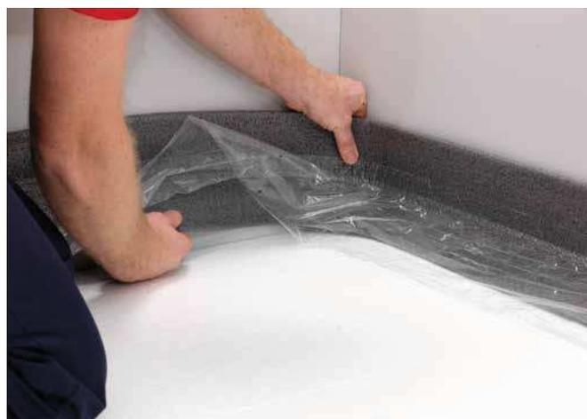
Lorsque deux couches d'isolation lisse ou une combinaison d'une isolation lisse et d'un panneau de système sont employés, l'isolation périphérique doit être posée sur la plaque d'isolation supérieure.
