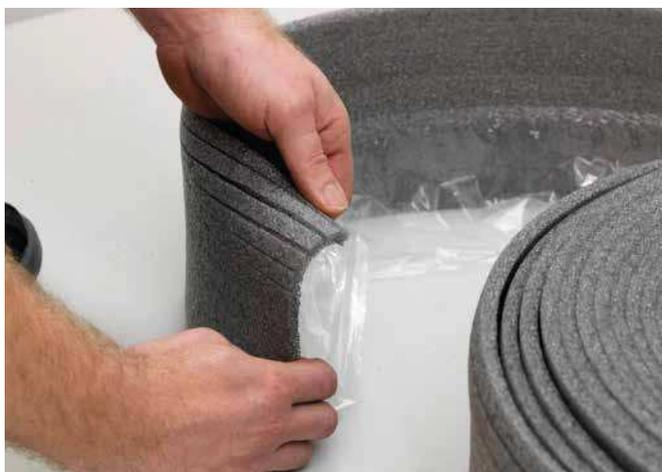
L'isolation périphérique est pourvue d'un rabat en PE qui est toujours orienté vers l'intérieur de la pièce. Les bandes à arracher se trouvent au-dessus.
