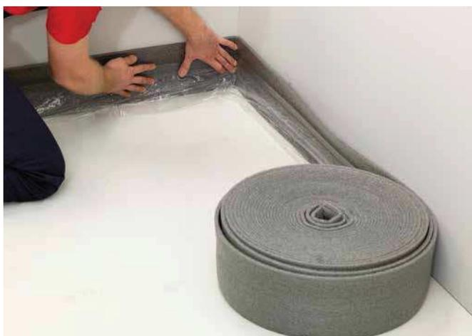
Tous les murs et constructions fixes doivent être équipés d'isolation périphérique. L'isolation périphérique doit être posée fermement et, si nécessaire, disposer de fixations supplémentaires.
